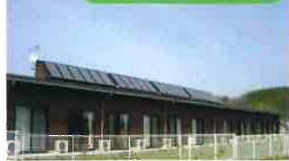
サービス付高齢者住宅、給湯
